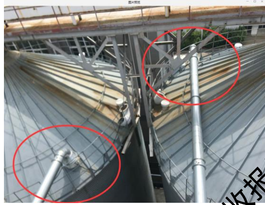
整改后筒仓呼吸口管道密封收集
