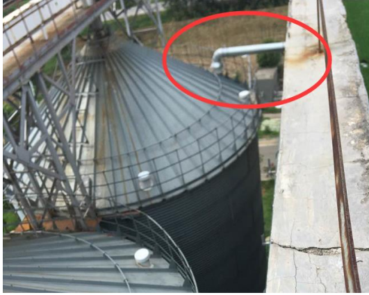
整改后筒仓呼吸口管道密封收集
