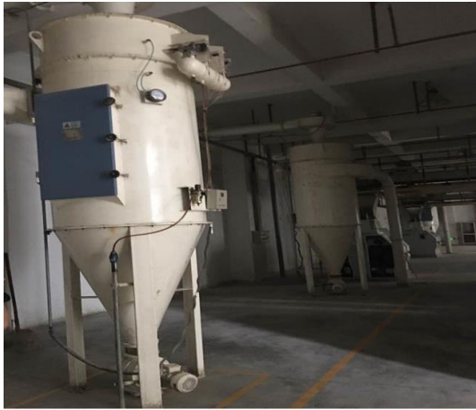
整改后粉碎工序脉冲布袋除尘器
