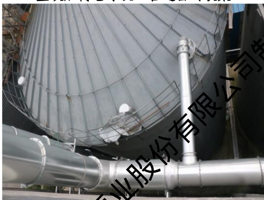
整改后筒仓呼吸口管道密封收集
