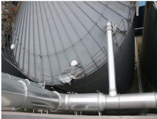
整改后筒仓呼吸口管道密封收集
