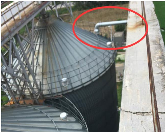
整改后筒仓呼吸口管道密封收集
