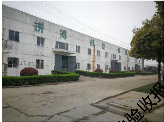
整改前 218 酿酒车间外部
