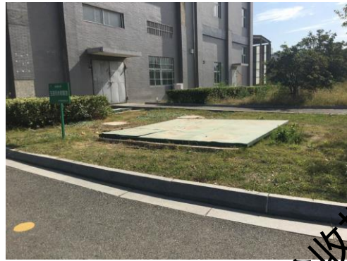
制曲车间生活污水收集池
