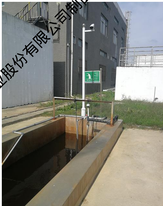
新区污水处理站排水口
