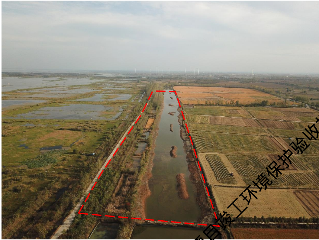
1号生态修复区实施后航拍图（2020年11月3日）
