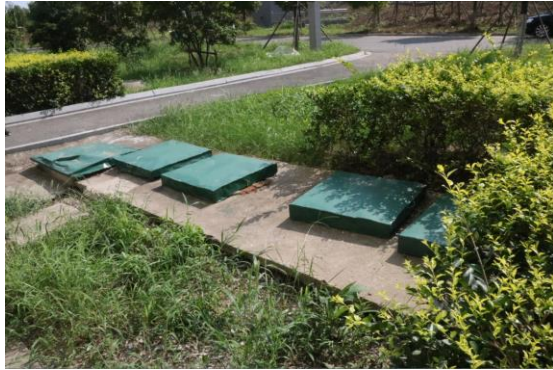
制曲车间化粪池
