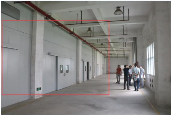
生产车间隔声墙
