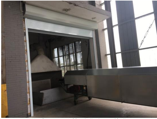
整改后原料输送集气罩收集
